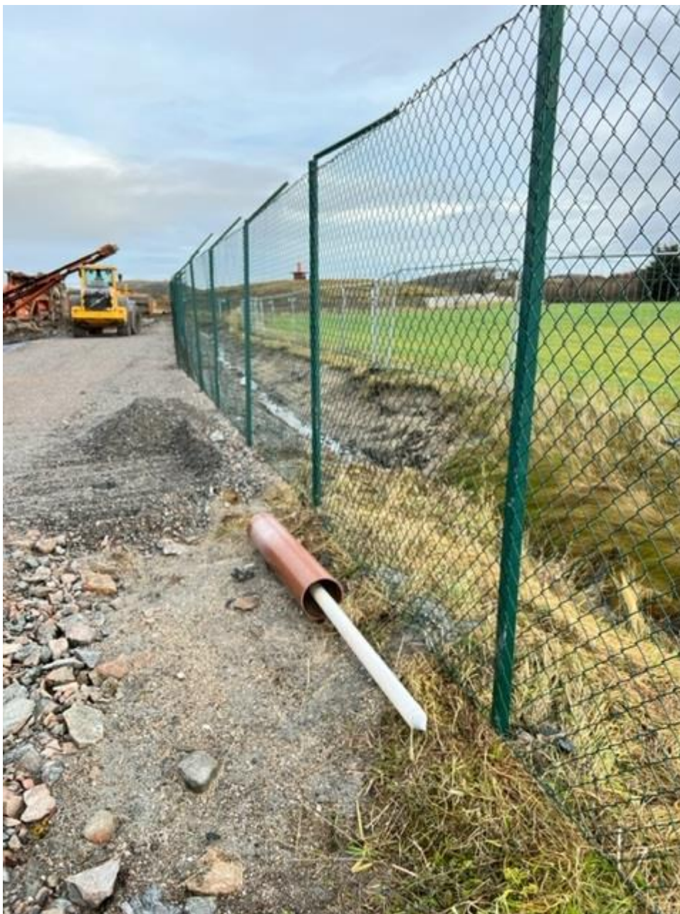
Figur 2-4: Bilde av OV-Grøft1.
