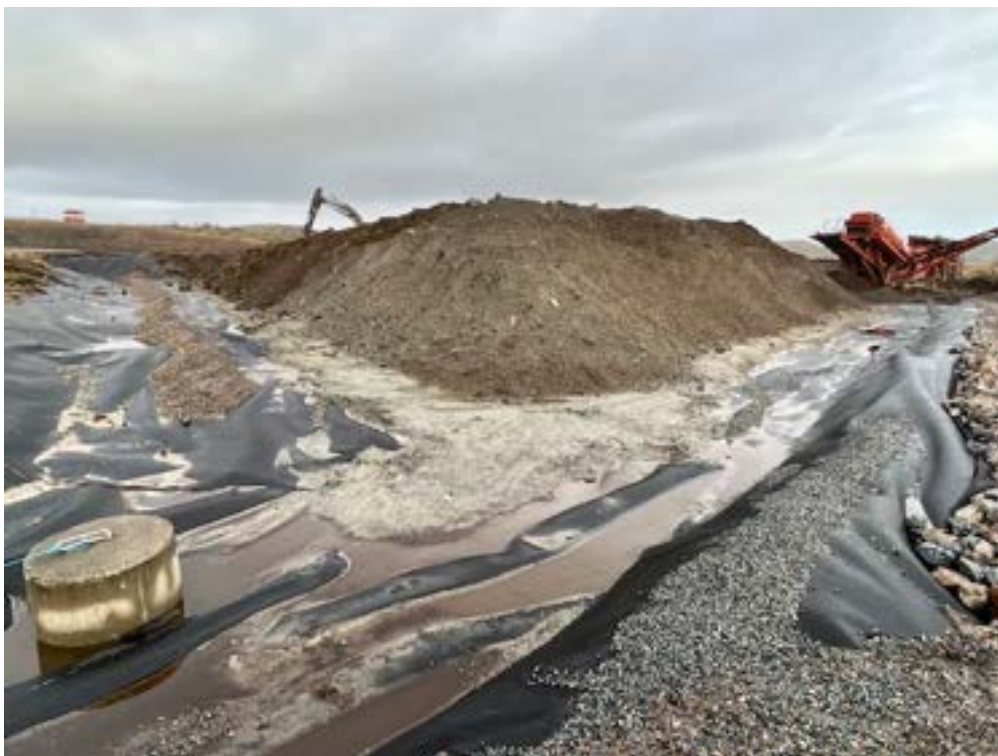
Figur 2-6: Øverste bilde er tatt etter utgraving av OV-grøft2. Masser ble gravd vekk ned til underliggende silt/leire/berg. Grøftene ble dekket med vanntett membran (PVC) for å lede vann fra det forurensede arealet mot bassenget, som vist i det nederste bildet.
