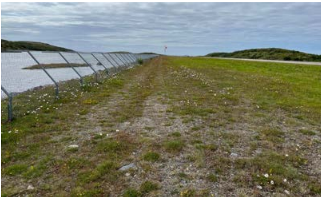
Figur 3-2: Anleggsveien ble lagt inne på fyllingen i et område hvor man ser tydelige spor etter kjøretøy i dag. Strandenga ligger på utsiden av gjerdet og flomforbyggingen ble ikke berørt.
