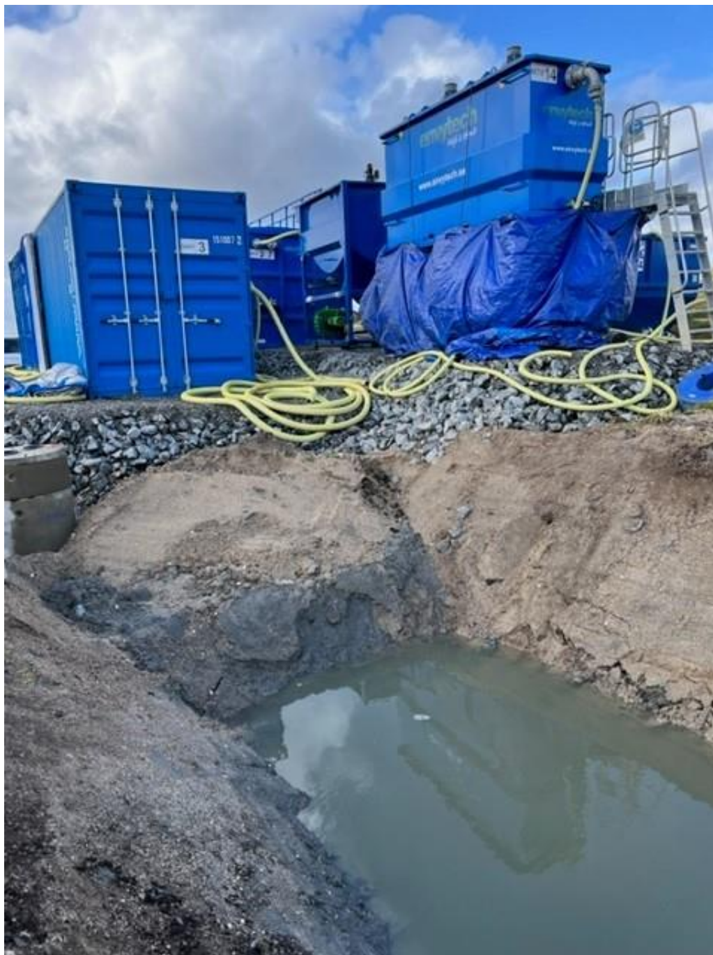
Figur 2-5: Bilde fra utgraving av fordrøyningsbasseng nedstrøms (sør for) tiltaksområdet. Masser ned til underliggende berg eller silt ble gravd vekk og området ble dekket med vanntett membran (PVC). Renseanlegg for oppsamlet anleggsvann vises som blå containere i bakgrunnen.
